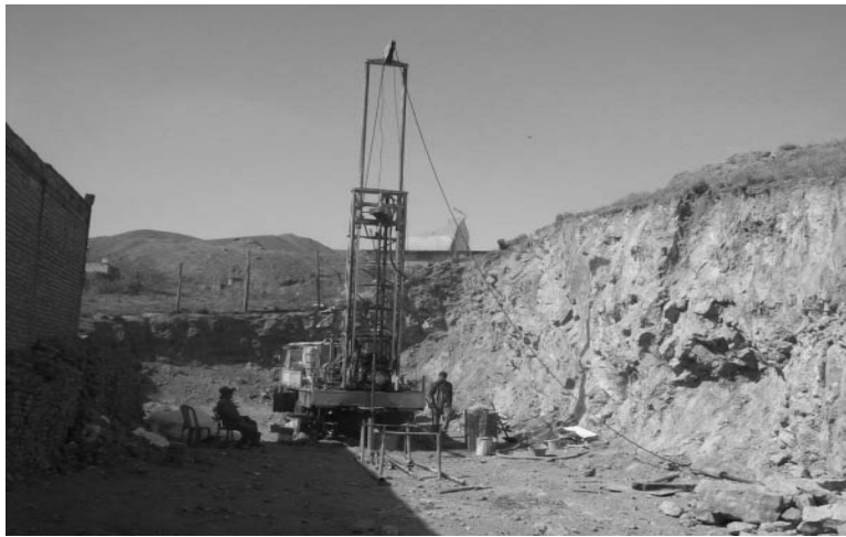
شکل شماره ۳-۱: نمایی از عملیات حفاری و نمونه برداری
