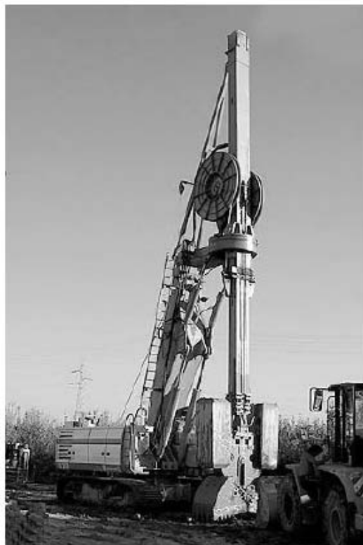
شکل شماره ۴-۲۷: مراحل اجرای دیوار دیافراگمی
