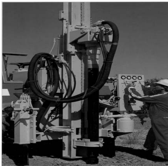
شکل شماره ۲-۱۱: نمونه ای از دستگاه حفاری دورانی در حال کار
