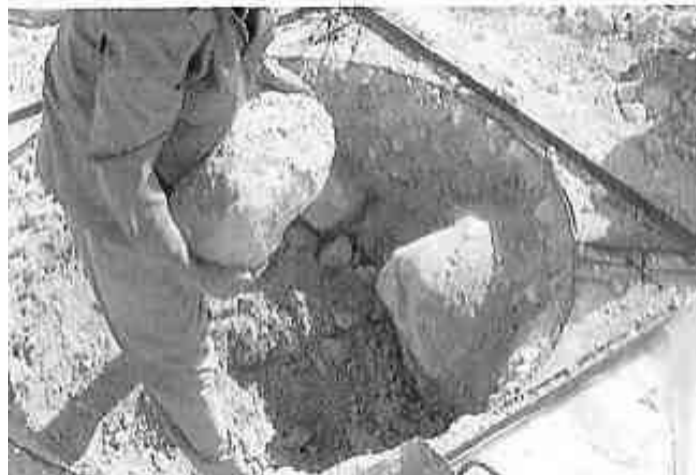
شکل شماره ۲-۲: حفر یک چاهک دستی
