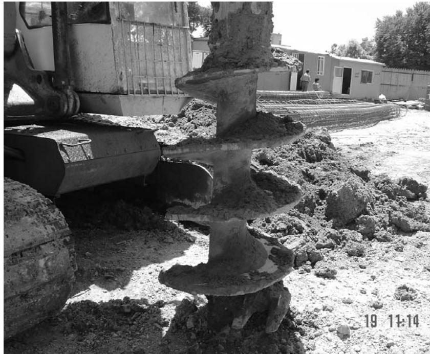
شکل شماره ۴-۳۰: دستگاه حفاری شمع
