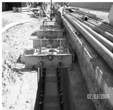
شکل شماره ۴-۲۷: مراحل اجرای دیوار دیافراگمی
