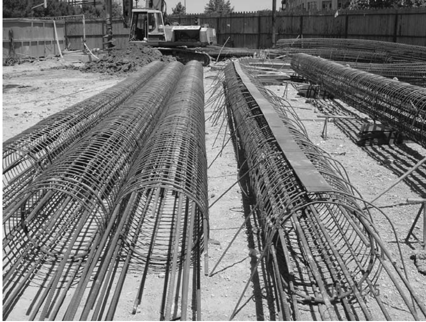
شکل شماره ۴-۳۱: قفسه های آرماتور مورد نیاز شمع درجا
