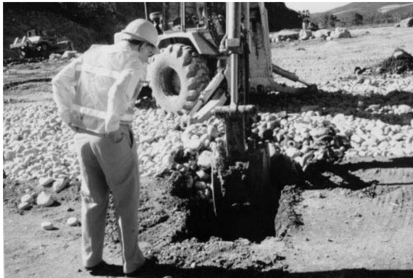
شکل شماره ۲-۴: نمونه ای از ترانشه حفر شده به وسیله بیل مکانیکی
