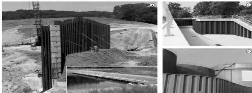
شکل شماره ۴-۴۱: نمونه ای از روش سپرکوبی
