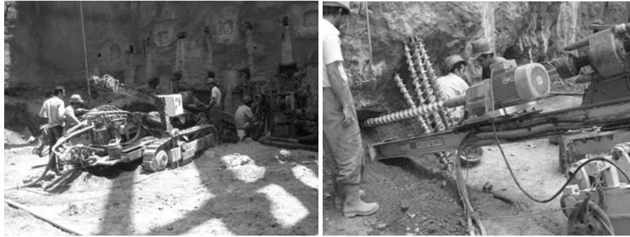
شکل شماره ۴-۳۵: سوراخ ها با توجه به طول، قطر، جهت و فواصل معین بر اساس طراحی
