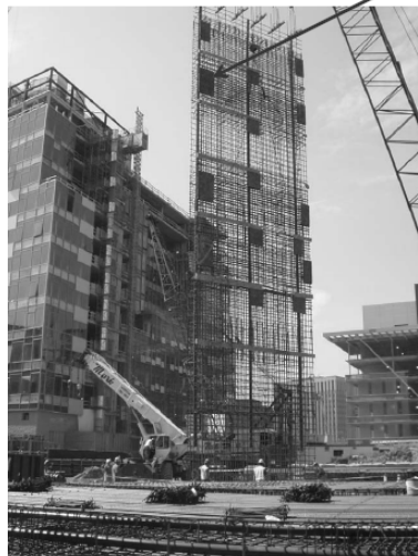
شکل شماره ۴-۲۷: مراحل اجرای دیوار دیافراگمی
