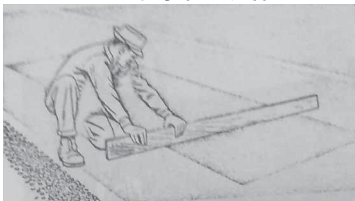
تصویر شماره ۴-۷: تراز نمودن با شمشه یا وسایل دیگر
