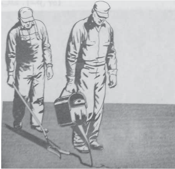
تصویر شماره ۴-۱۲: ریختن قیر در ترک انعکاسی
